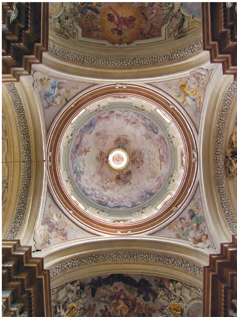
8. Kraków, kościół św. Anny, wnętrze kopuły, fot. M. Kurzej 2007
